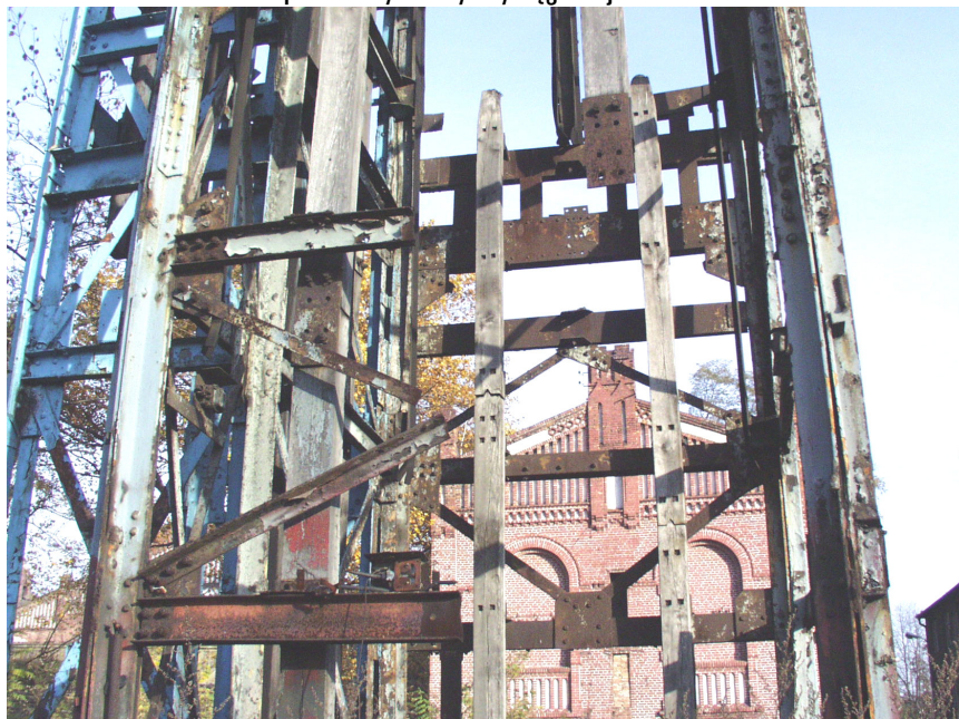
Fot. 3 Widok uszkodzeń podstawy wieży wyciągowej.
