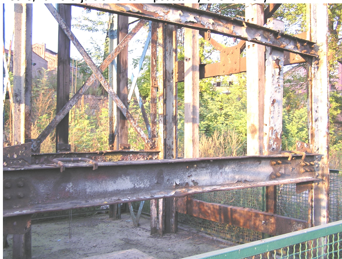
Fot. 9,10 Korozja elementów podstawy trzonu wieży.
